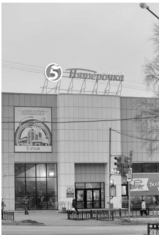
Конструкцию на крыше придется убрать?
