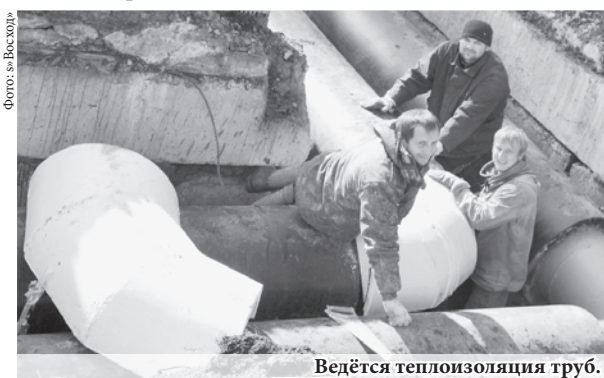
Ведётся теплоизоляция труб.
