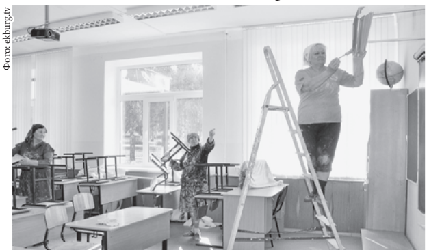
Впереди – ремонт школ.
