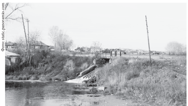
На реконструкцию ГТС Ачита потребуется 30 млн. рублей
