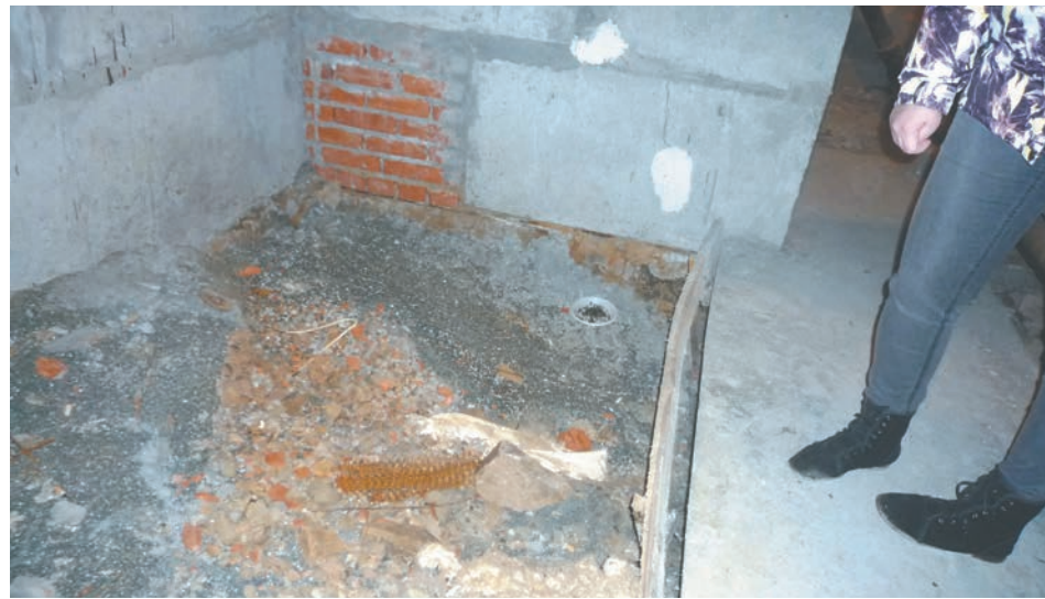
В подвале не один провал, есть ямы диаметром до двух метров
