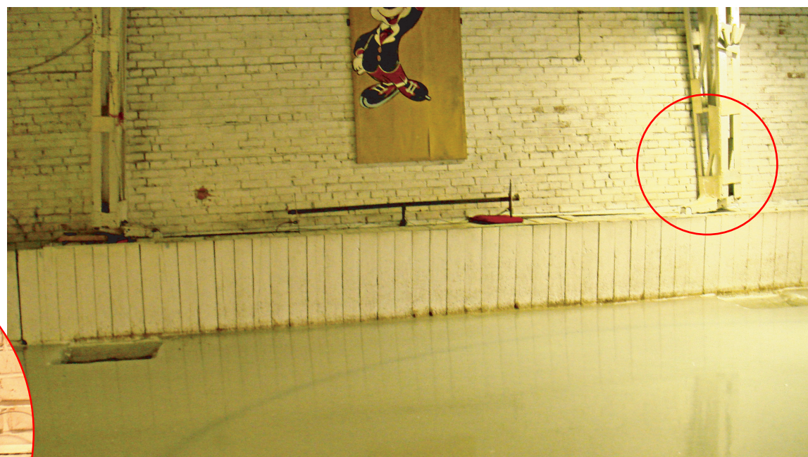
«Подломленная» опора фермы
