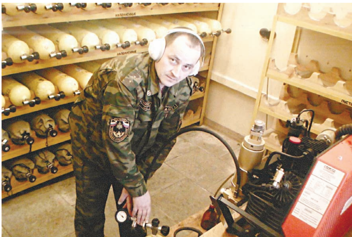
На базе ГДЗС Сергей заполняет баллоны воздухом
