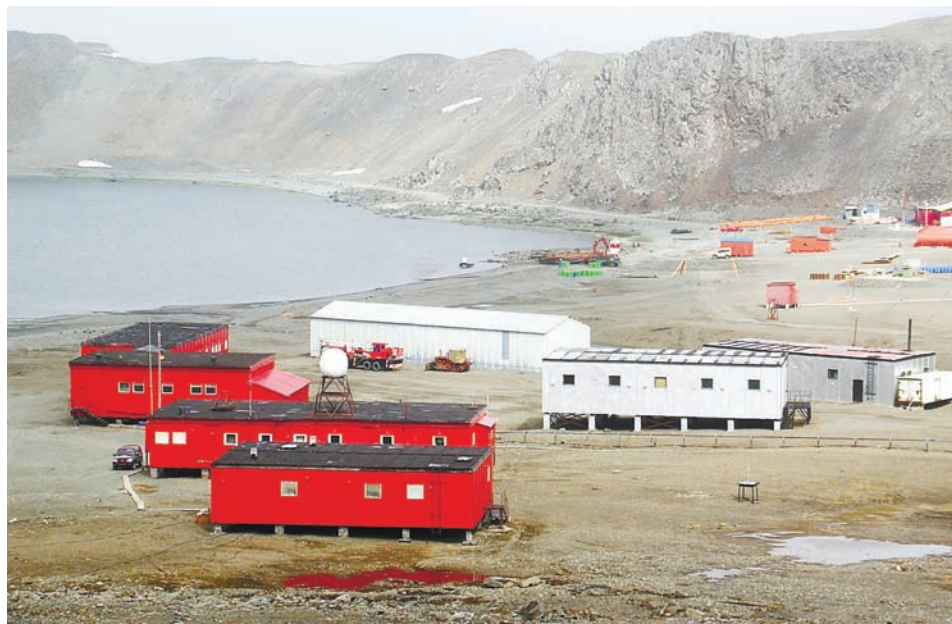
Такие вагончики-базы обычно устанавливаются на побережье
