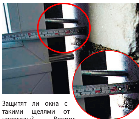
Оконщики решили, что одного дюбеля вполне достаточно для крепления рамы
