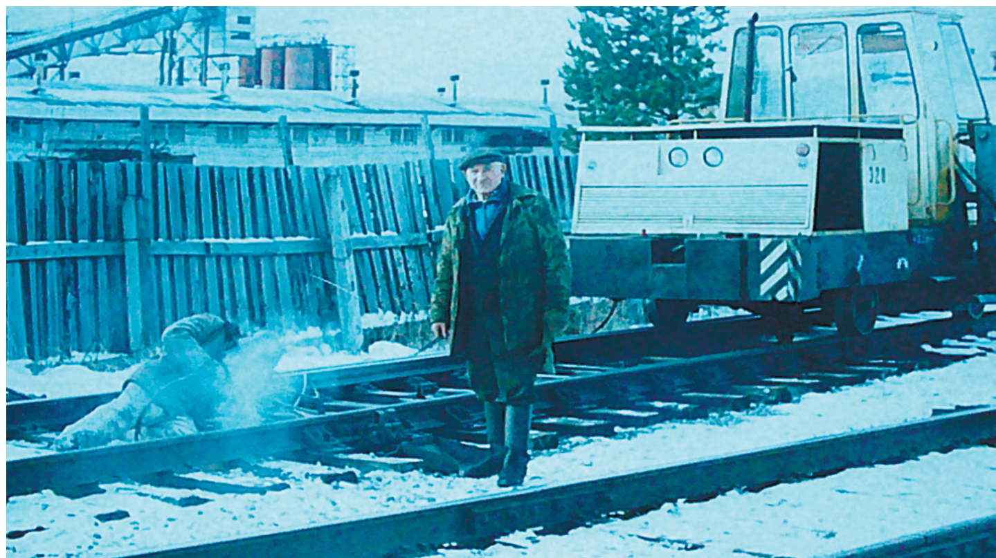
Рабочий момент на ж/д станции «Заводская»
