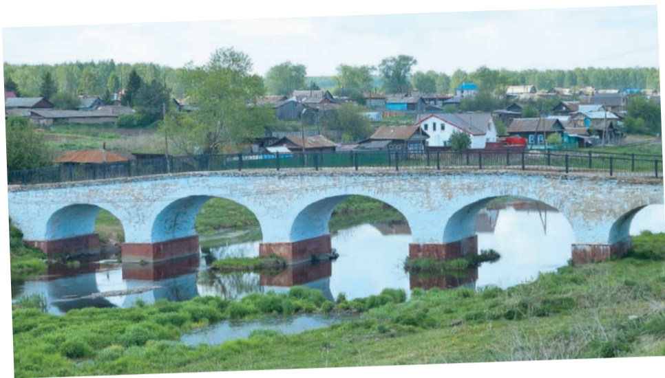
Мост через реку «Багаряк»
