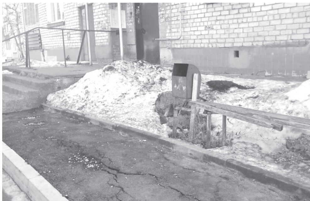
Улица Строителей, дом № 12. В ноябре делали ремонт, прошла зима, и асфальт сошёл со снегом...
